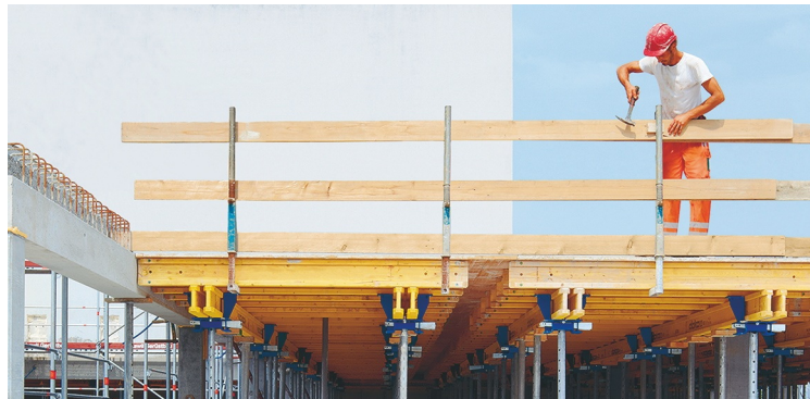
Abb. 3.65: Use Case »Absturzsicherheit« – Seitenschutz auf einer Baustelle
